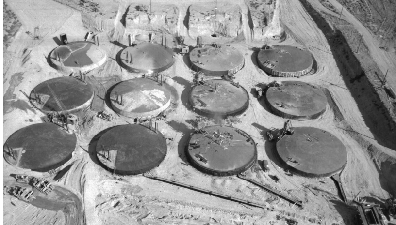
Figure 4: Cuves en béton servant de réservoirs à déchets radioactifs sur le site d'Hanford
