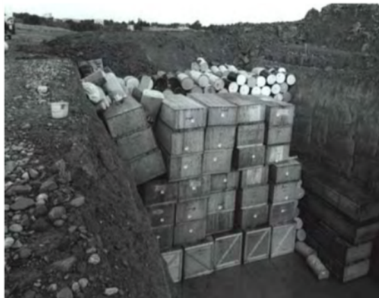
Figure 6: Caisses et fûts de déchets radioactifs empilées dans une zone d'élimination de West Valley. Noter l'accumulation d'eau sur le fond de la tranchée. [7]
